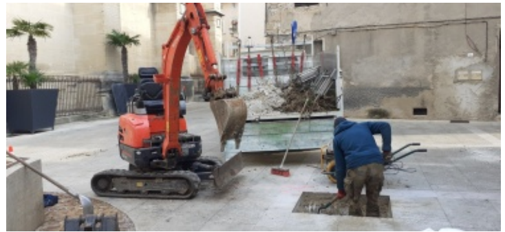
Exemple de travaux : plantation de deux frênes place Saint Siffrein
